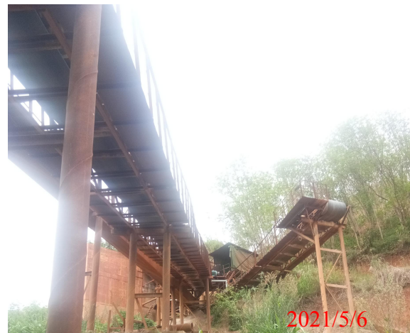
项目区给料工段现状 6
