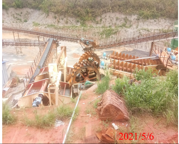
项目区脱水工段现状 2
