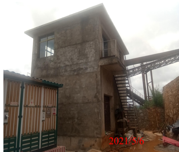
项目区控制房现状 4
