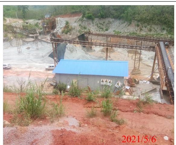
危险废物暂存间现状 12
