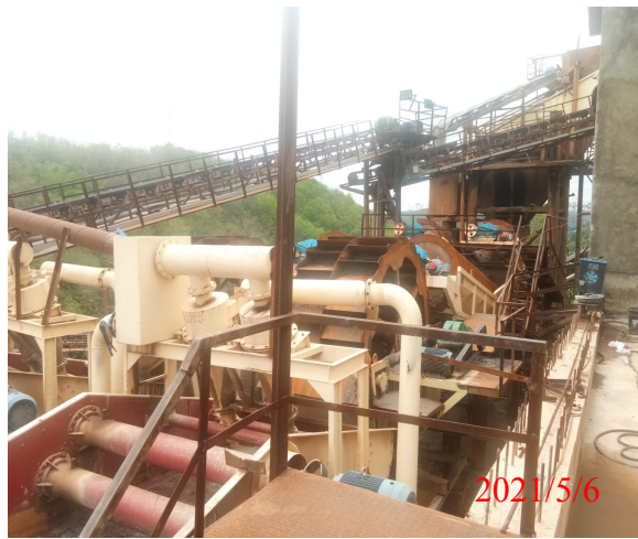
项目区脱水工段现状 3
