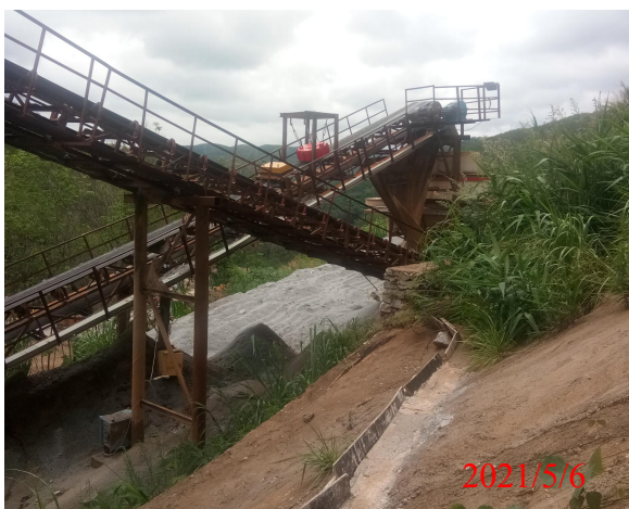
项目区制砂工段现状 5
